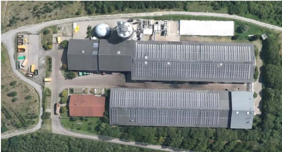
Luftbild Vergärungsanlage Leonberg
